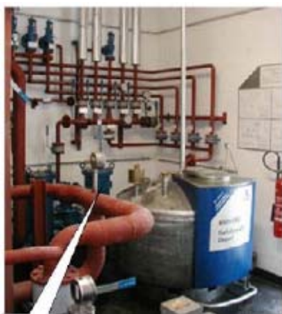
Рис. 4.27 Насосная станция 2 с фильтром и контейнером для сбора отфильтрованного материала
