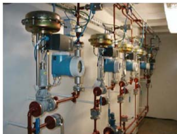
Рис. 4.28 Система для измерения и дозирования с пневматическими клапанами
