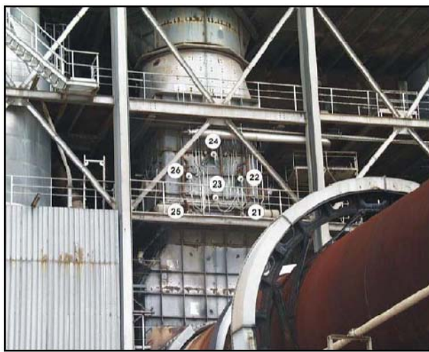
Рис. 4.8 Высокоэффективная технология SNCR и участок размещения трубок с 21 по 26 для впрыскивания аммиачной воды [76]
